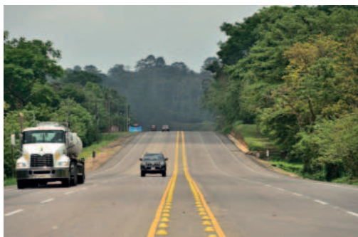
Foto: Radio House
