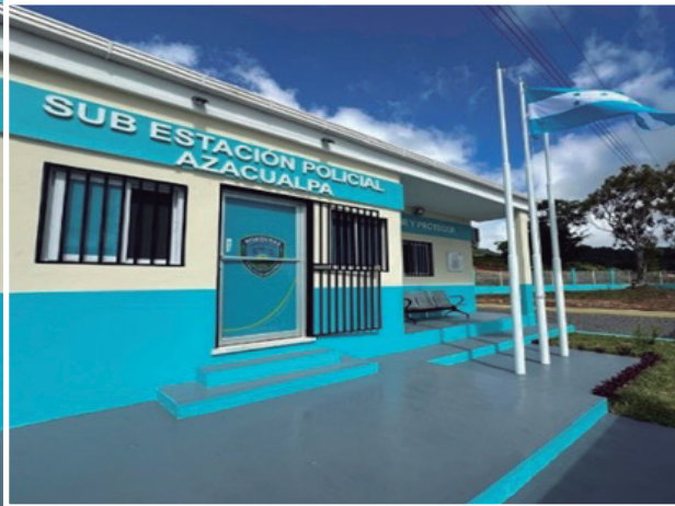
Sub Estación Policial Azacualpa Fco. Morazán
