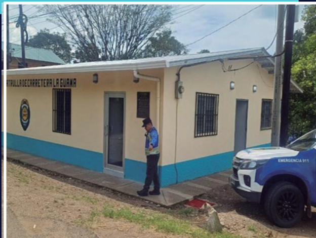
Posta de Patrulla de Carretera, Guama, Santa Cruz de Yojoa
