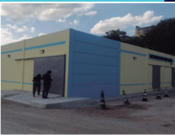
Área de Mantenimiento de Logística
