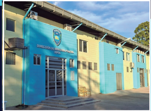
Nave de Industria Policial Comayagua
