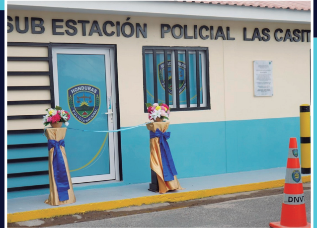
Sub Estación, Las Casitas, F.M.
