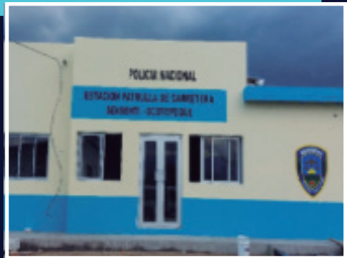
Posta Patrulla de Carretera, DNVT Sensenti, Ocotepeque
