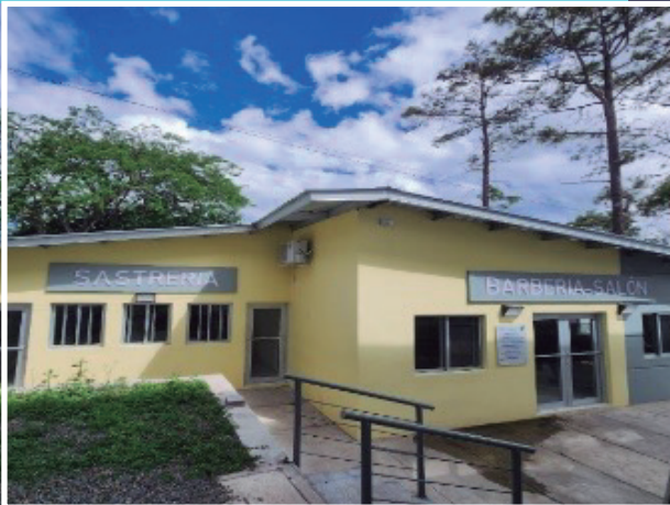
Edificio de Áreas Técnicas, Complejo SEDS
