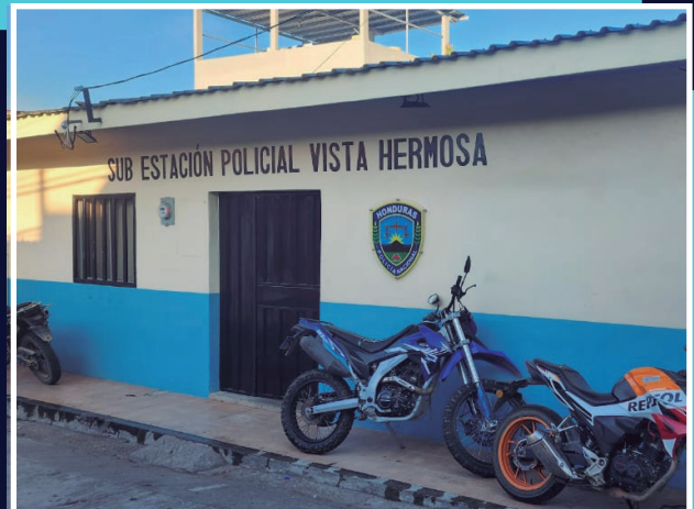
Sub Estación Vista Hermosa F.M.
