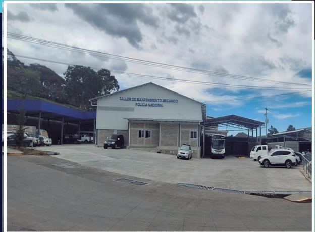
Hangar de Transporte de Equipo Pesado y Taller Mecánico
