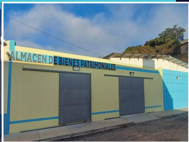
Bodegas de Almacenamiento de Bienes Patrimoniales
